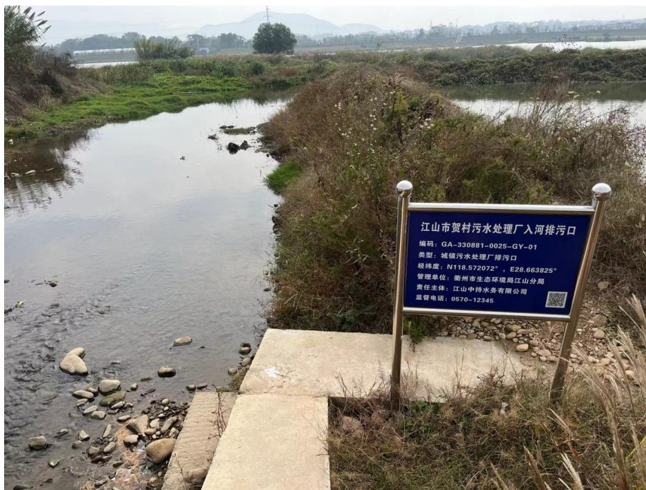
图10-6 项目江山市贺村污水处理厂入河排污口标识牌
